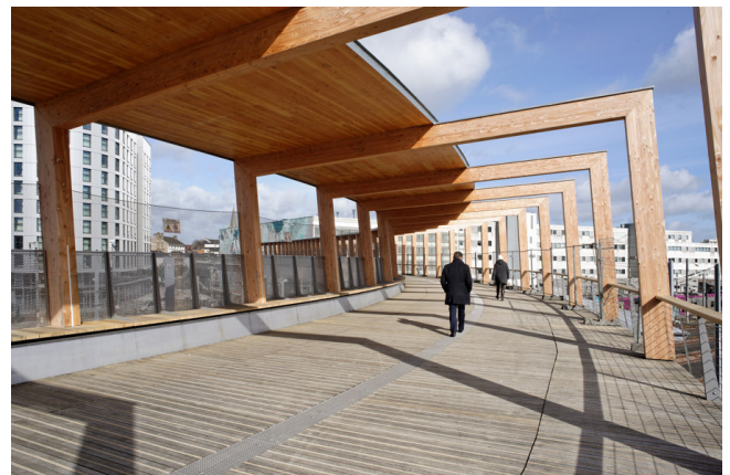
Referenz: Bahnhof Saint-Laud TGV, Passerelle
